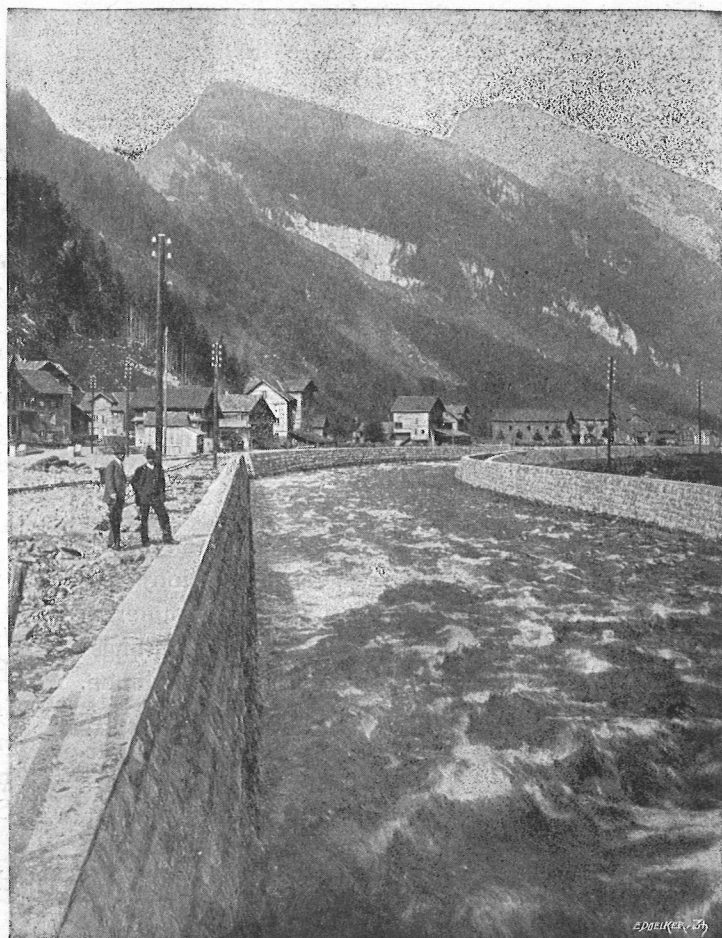
Die Muotakorrektur. Abb. 9. Leitwerke unterhalb der Brücke Hinterthal. August 1915.
